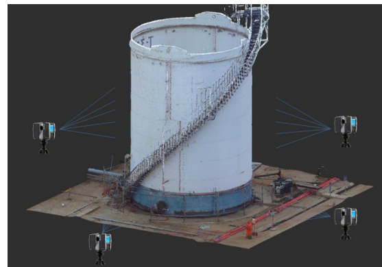
Registro estanque compañía Minera
